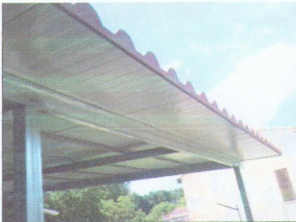
esempio di tettoia in acciaio con copertura in isopak
